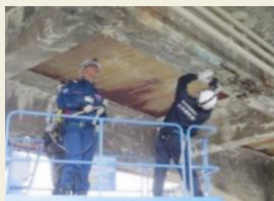
写真1：橋梁の直轄診断の様子
