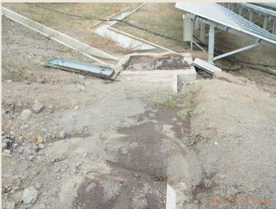
排水計画の瑕疵により開水路に堆積した土砂
